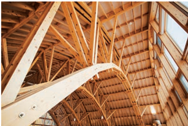
エントランス架構
