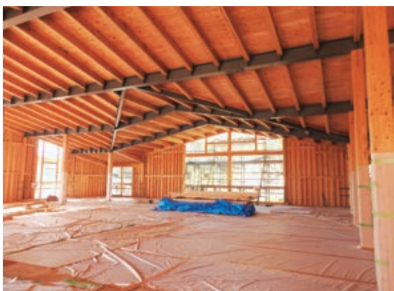
大会議室架構（鉄骨と木のハイブリット）
