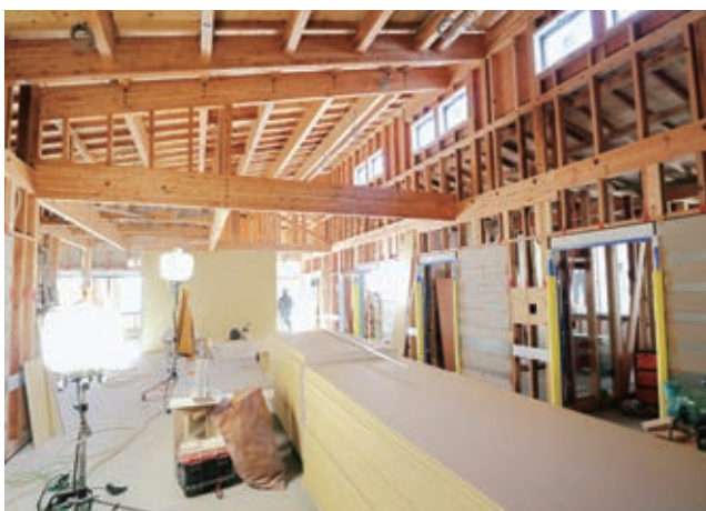
工事中的様子
