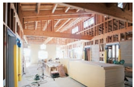
富士楽寿園施工中の様子
