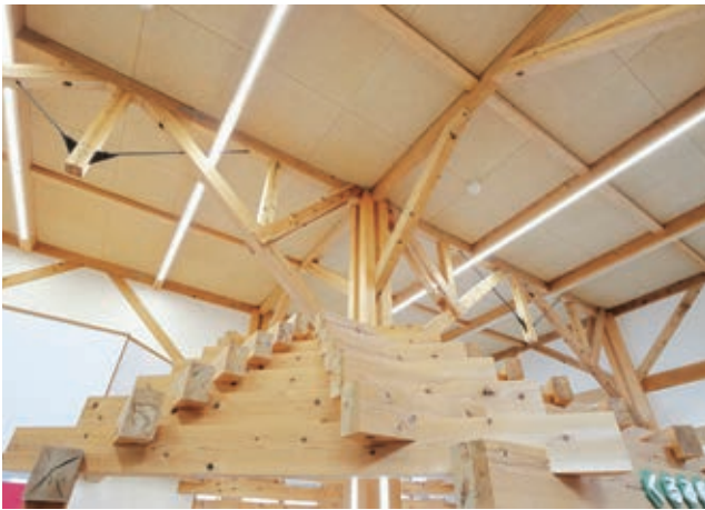
玄関ホール架構
